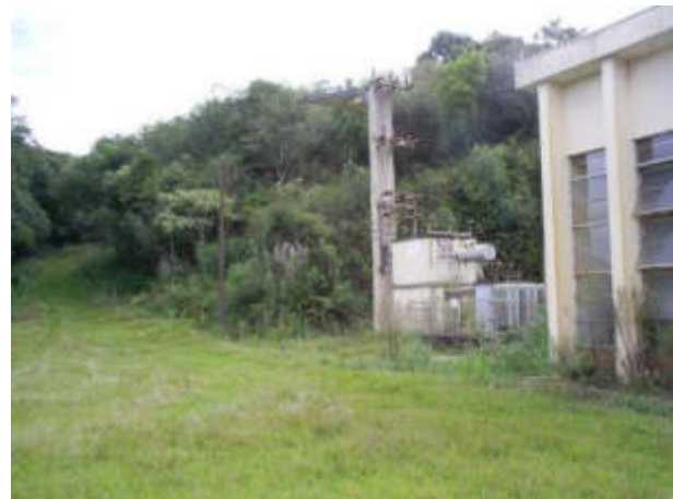
FOTO 26 – FOM ALUVIAL ALTERADA NO ANTIGO SÍTIO DE OBRAS DA USINA DESATIVADA. FONTE: AMBIOTECH, 2021a.
