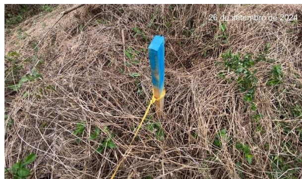
FOTO 44 – ESTACAS PINTADAS DE AZUL PARA MELHOR VISUALIZAÇÃO EM CAMPO FONTE: AMBIOTECH, 2024.
